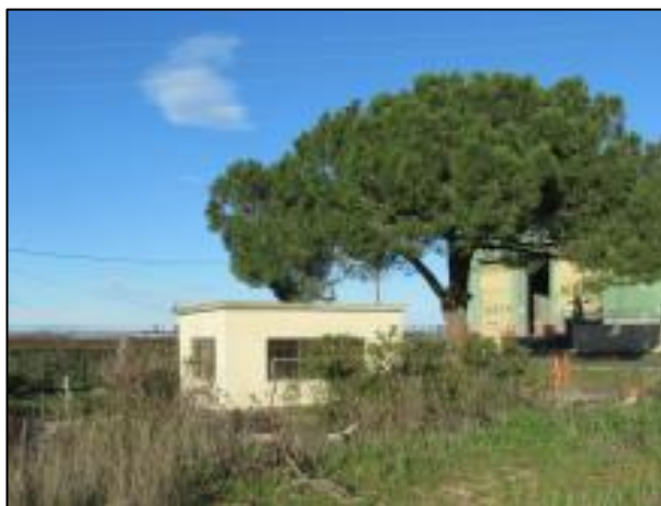
Figure 9 : Vue du bâtiment à démolir
