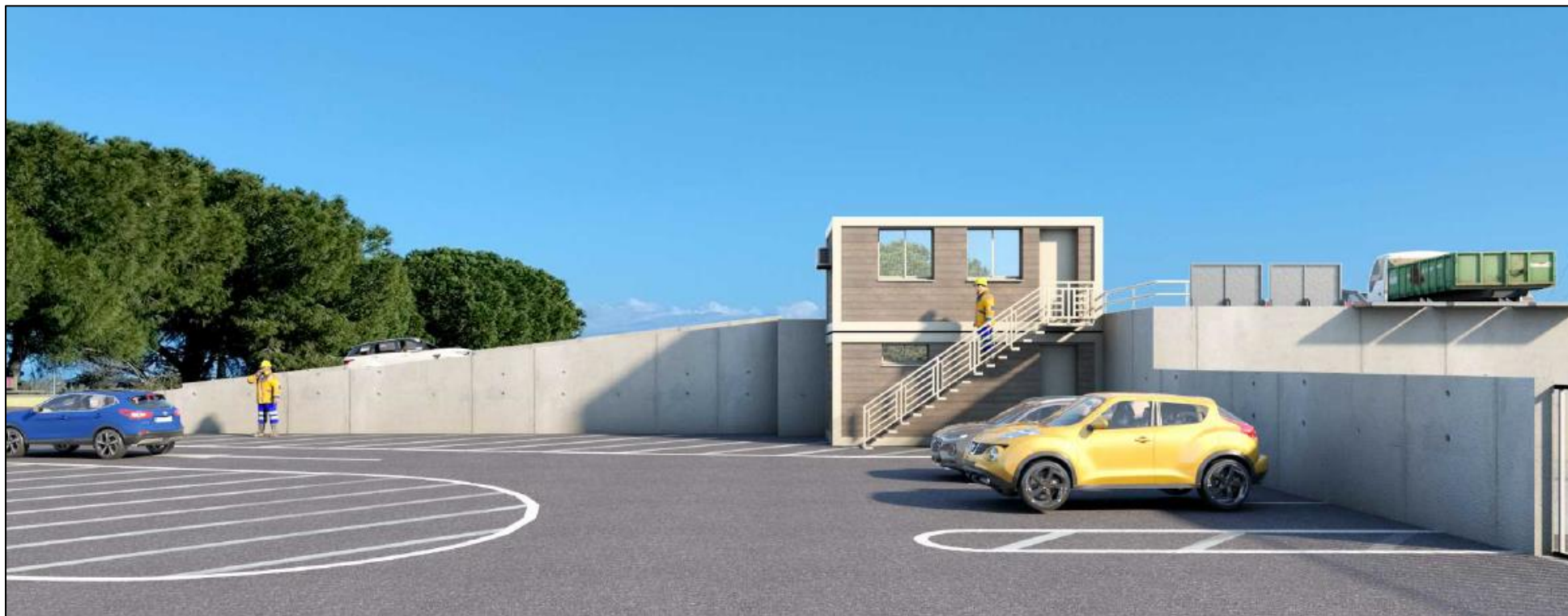
Figure 8 : Vue de la rampe d'accès à la plateforme et du local du personnel depuis l'Ouest (source : Agence d'architecture Escamez)
